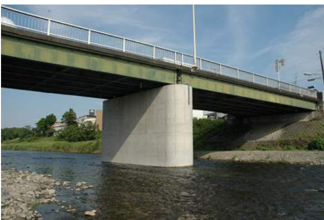
耐震補強工事により、太くなった中橋の橋脚と、入間川の水の流れ
