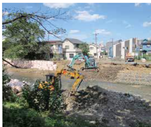
市営霞川団地前の緊急護岸工事
