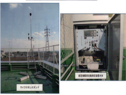
東町小学校屋上に設置された航空機騒音測定器
