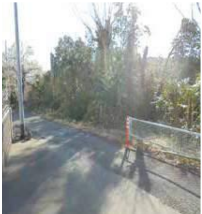
上橋大けやき沿い市道の防護柵
