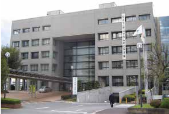
耐震化が急がれる市役所庁舎
