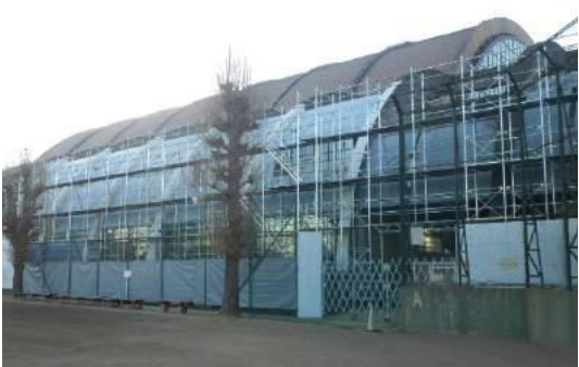
工事中の市民体育館
