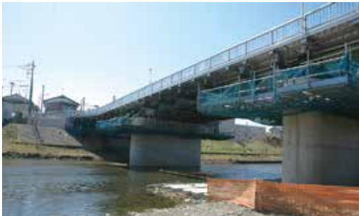
入間川の河原から、中橋を見上げる。橋脚と橋桁の接合部に、足場を組んでいる。
