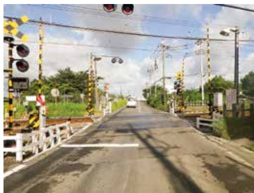
現在の武蔵藤沢第4号踏切のようす
