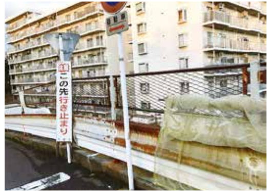
錆のひどい小谷田ガーデンハイツ周辺のガードレール
