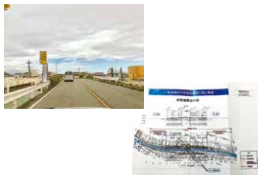
武蔵藤沢駅に隣接している工事前の建武橋（左）と仮設道路全体予定図（右）
