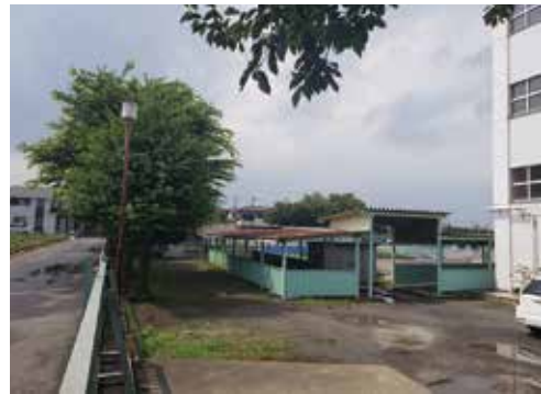
移転新築の候補地である藤沢北小学校のプール渡り廊下西側
