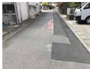
上水道工事施工後の道路
