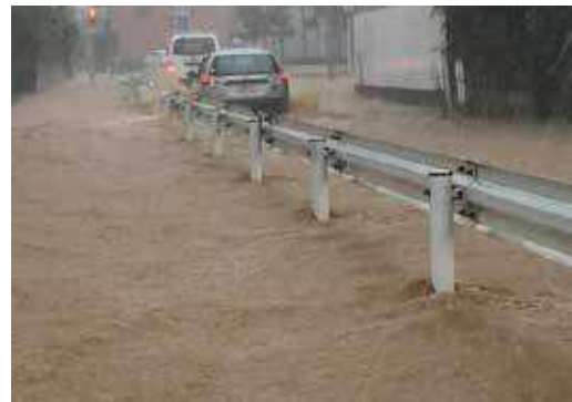
大雨のたびに氾濫する禊(みそぎ)川(宮寺保育所付近)
