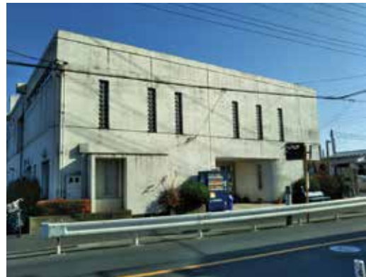
公共施設の統廃合で廃止となる予定の高倉公民館
