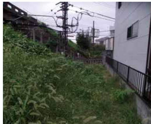
建武橋と民家 2車線の仮設道路ができる東側
