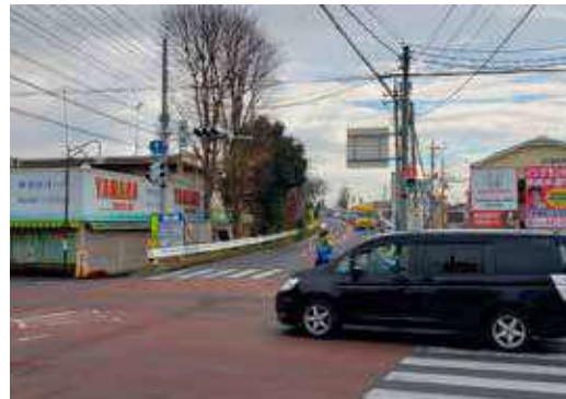
渋滞による迂回車両の生活道路進入対策が不十分なまま工事開始予定の建武橋
