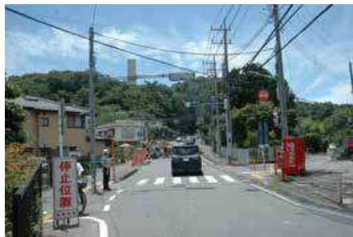
北から金子坂を望む。水道の配水管工事のため、片側交互通行となっている。
