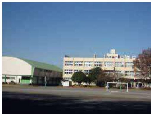
藤沢南小学校の校舎と体育館
