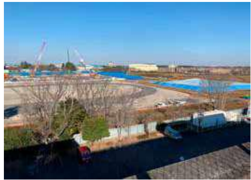
旧東町側留保地の整備経過の様子
