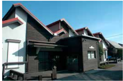
『入間市文化創造アトリエ』（愛称アミーゴ）。のこぎり屋根が連なるホール。
