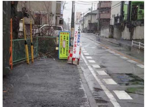
工事が延期になっている仏子やかん坂
