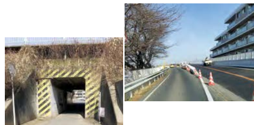
3月18日上下線が通行可能となる建武橋(仮橋)と改善を願う地下道F417号線
