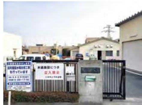
マイクロ水力発電設置候補地となる 市内4か所の配水場の1つ扇町屋配水場
