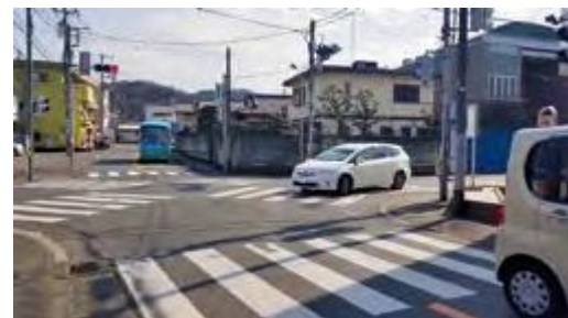
高度化PICSの設置が望まれる 県道195号富岡入間線仏子駅入口交差点
