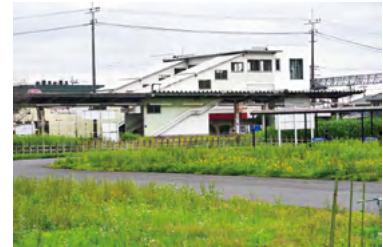
元加治駅南口駅前交通広場の 設置予定地
