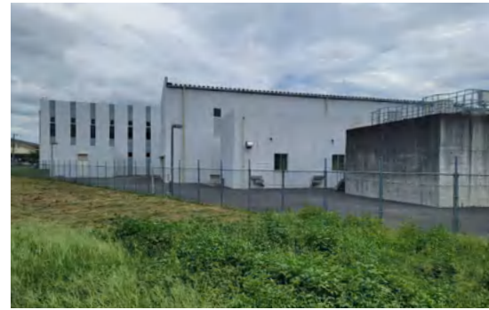
入間川の土手から見た鍵山浄水場
