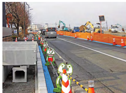
踏切に続く市道幹2号線拡幅工事の様子
