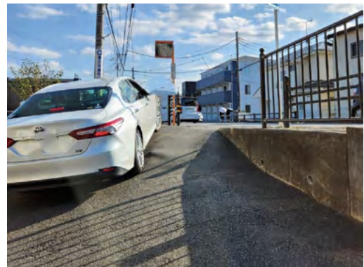
国道 463 号と市道 F25 号線の危険な合流箇所
