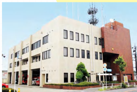
埼玉西部消防局 所沢中央消防署
