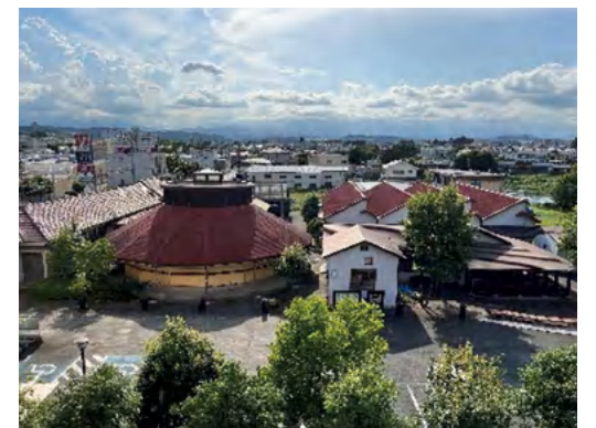
文化創造アトリエの全景
