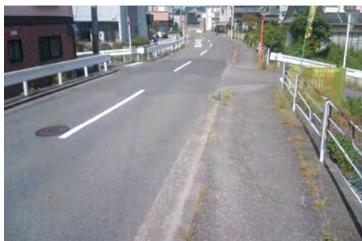
上橋南側の片方しか歩道がない市道
