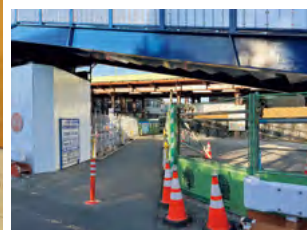
建武橋下の横断函渠
