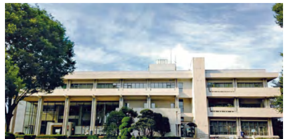
令和3年4月から閉鎖している旧市民会館
