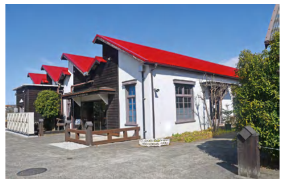
愛称「アミーゴ」の文化施設棟の中核 赤いこぎり屋根のホール・ギャラリー
