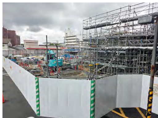
入間市役所の工事現場
