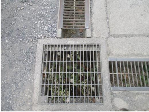
U字溝のグレーチング蓋の間に生じていた隙間
