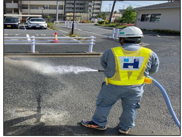
道路清掃状況
