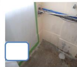
②関係機器類の設置・石綿円筒管撤去
