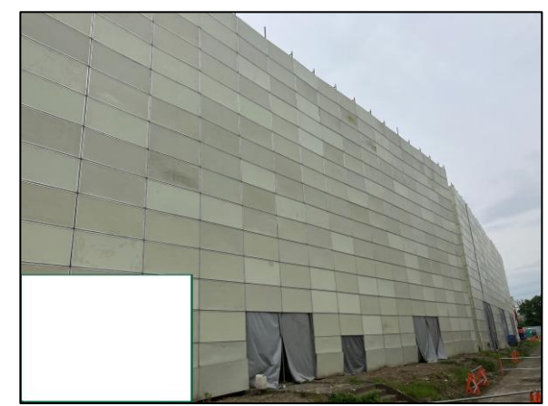
防音パネル設置状況 (参考)
