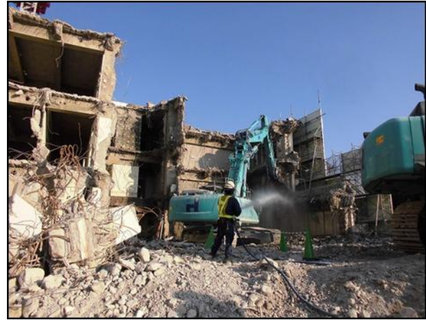
上屋解体 + 散水状況 2
