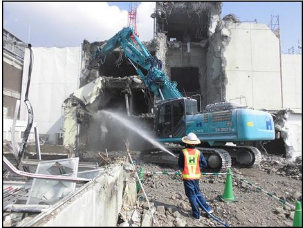
上屋解体 + 散水状況 1
