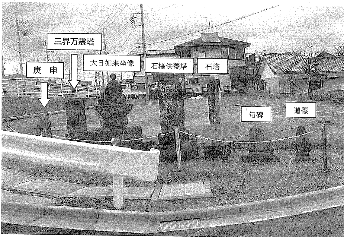
藤沢橋改修後の状況
