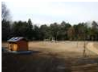
公園内で最初の施設となる「山仕事の広場」の全景
