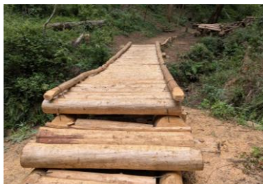
加治丘陵さとやま計画区域内 自然探勝路(丸太橋設置後)
