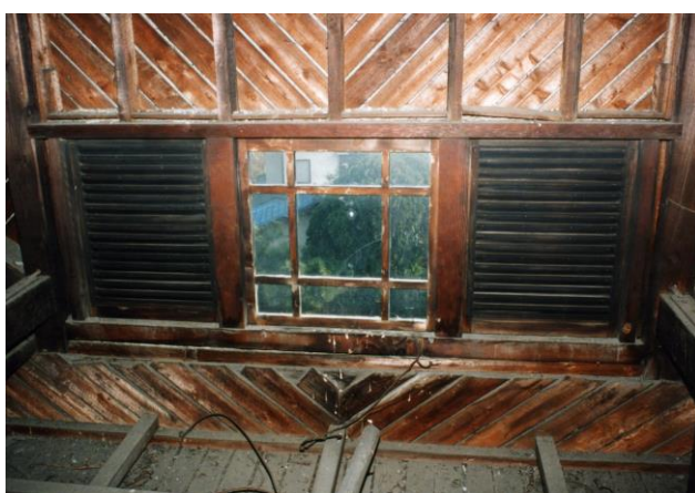
写真 10 本館小屋組み
