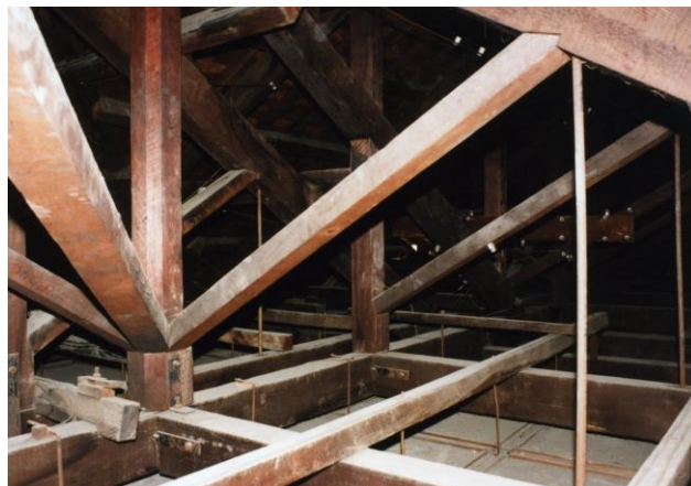
写真 9 本館小屋組み
