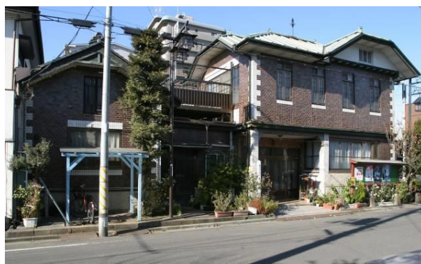
写真 板倉家住宅
