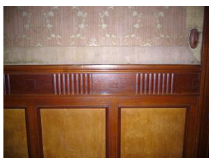
応接室壁腰板
