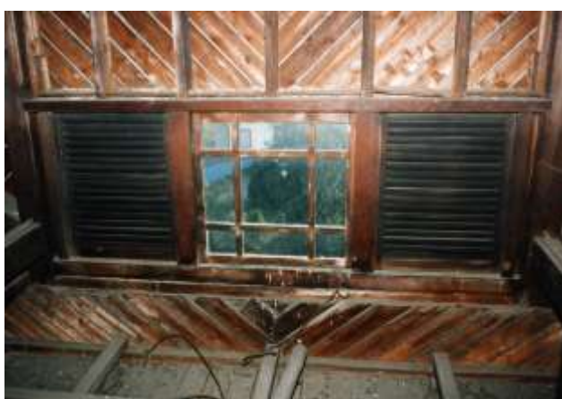
写真10 本館小屋組み
