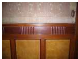
応接室壁腰板
