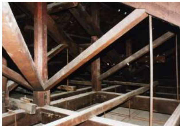
写真9 本館小屋組み
