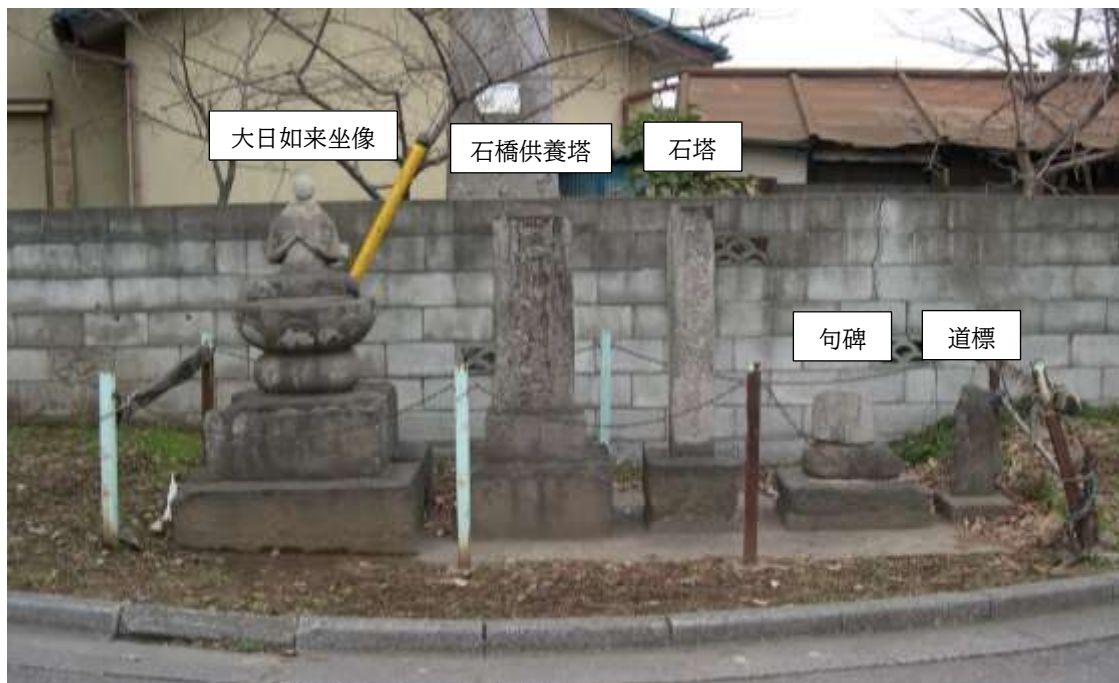
藤沢橋改修前の状況
