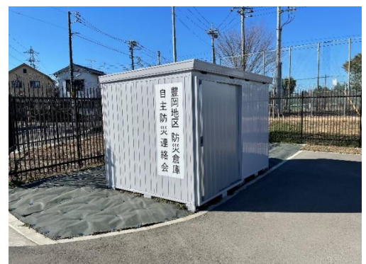
★東町防災倉庫（入間基地東町門前）
