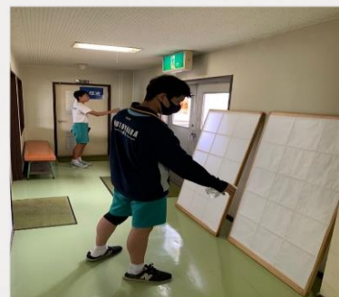
和室の障子の張替え作業
