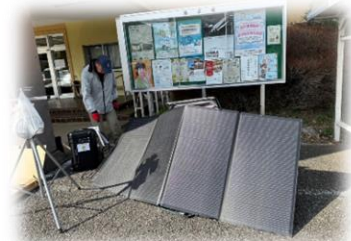
★ソーラーパネルでの発電と蓄電池への蓄電
