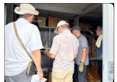
発電機を運転させ LED 投光器の確認
