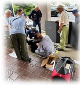
★黒須防災倉庫(黒須地区センター裏)の点検
